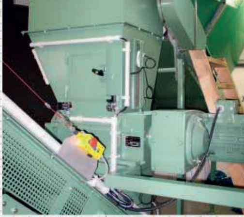
Zerkleinerer unter einem Abwurfschacht in einem Verwaltungsgebäude
